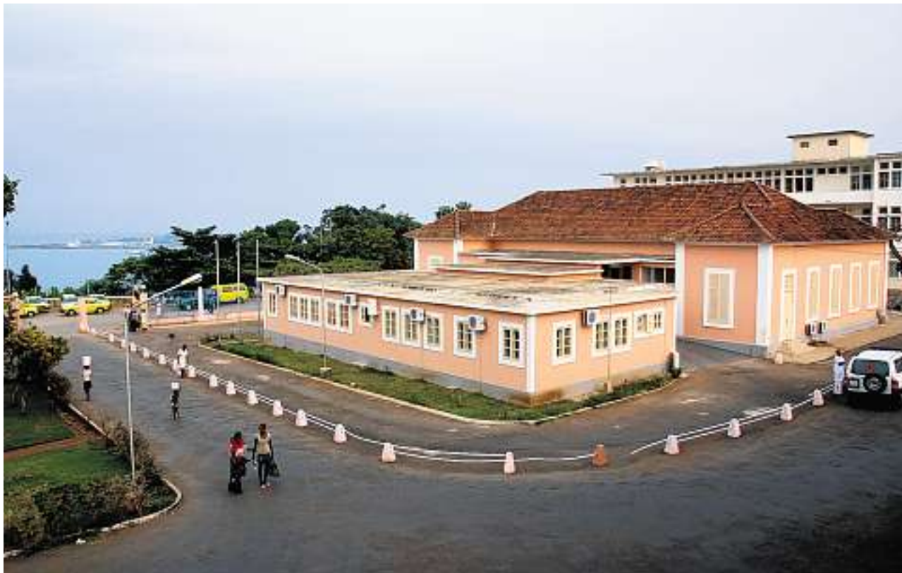
Erst gerade saniert und umgebaut: Die Notaufnahme des Spitals Sao Tomé kann sich mittlerweile sehen lassen.
